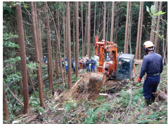
バックホウによる森林作業道作設
