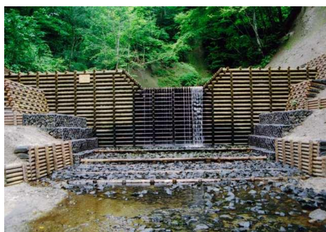
間伐材を活用した木製谷止工（十和田市） 津波災害復旧工事（三沢市）
