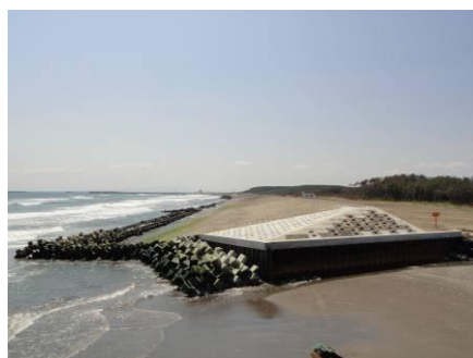
津波災害復旧工事（三沢市）
