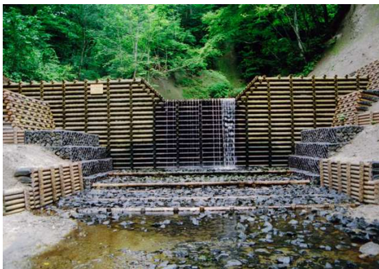
間伐材を活用した木製谷止工（十和田市・平沢）
