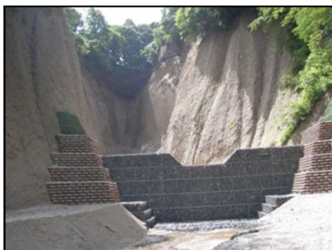
荒地に設置した谷止工（十和田市）
