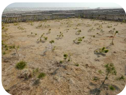
H29完成した植栽工（31.3撮影）
