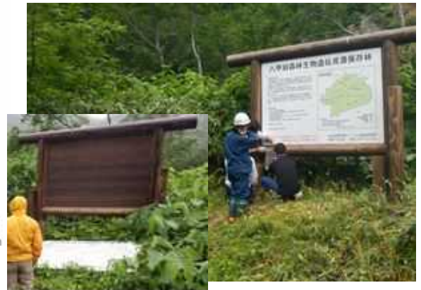
職員による看板の補修
