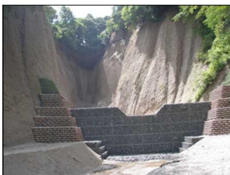
荒廃地に設置した谷止工（十和田市）
