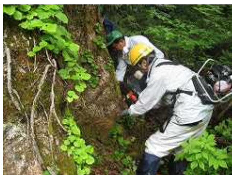
(ドリル穿孔作業風景)
