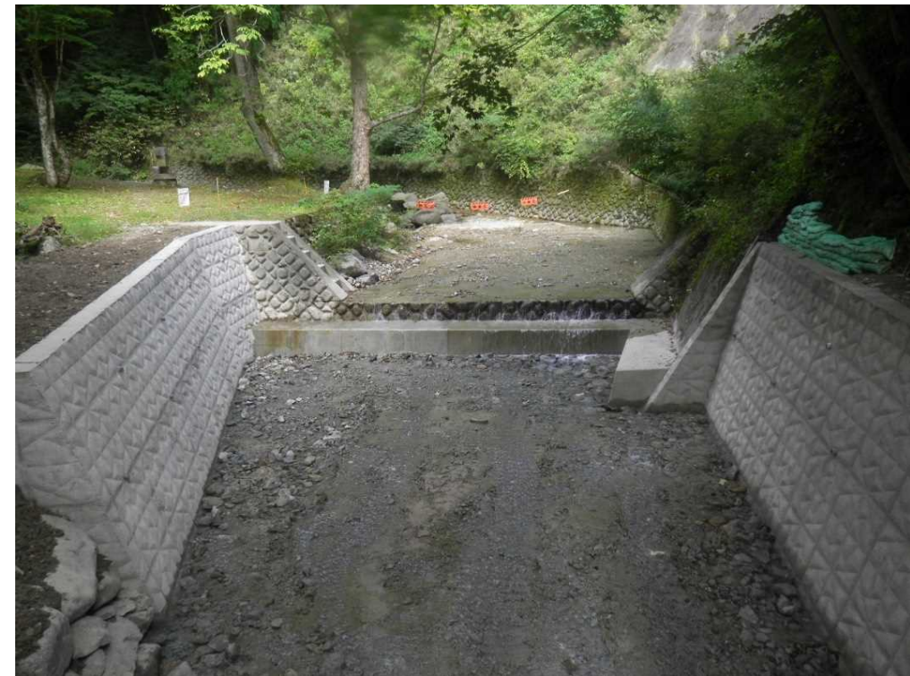
溪間工による荒廃溪流の復旧 (矢巾町北ノ沢地区)
