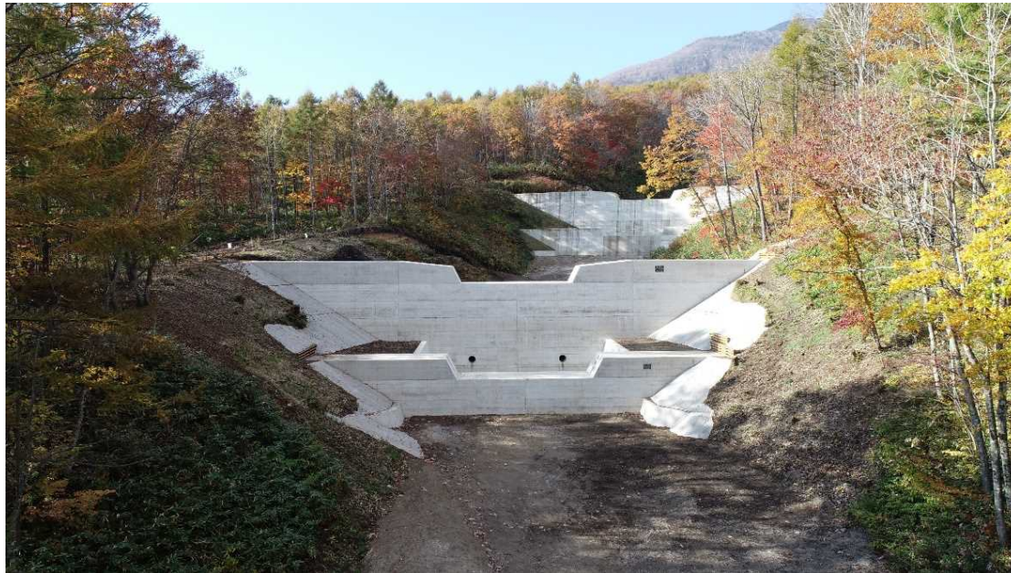
溪間工による火山防災対策 (雫石町熊沢地区)
