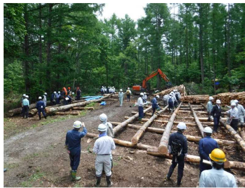
2. 現場の風景（全景）
