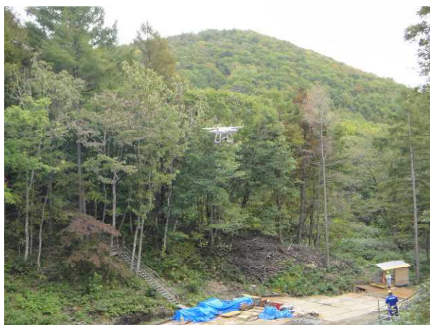
ドローンによる施工管理
