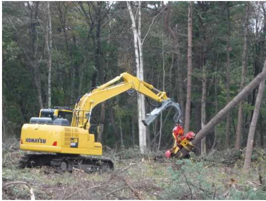
ハーベスタによる伐倒状況
