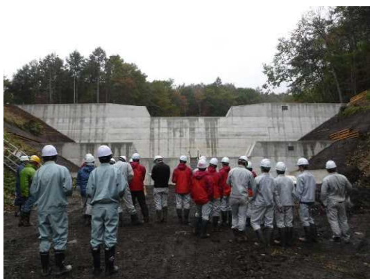
治山ダムの概要説明
