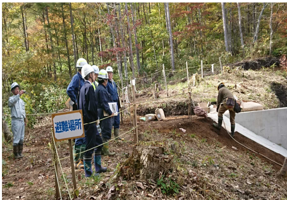
（治山現場の作業点検）
