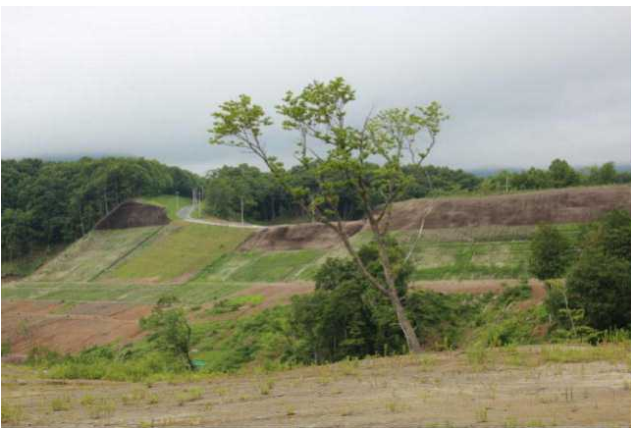
大規模山腹崩壊地における治山工事 (栗原市 耕英南地区)
