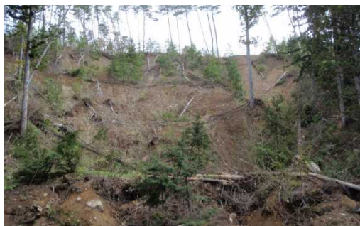
被災状況(H25年5月)
