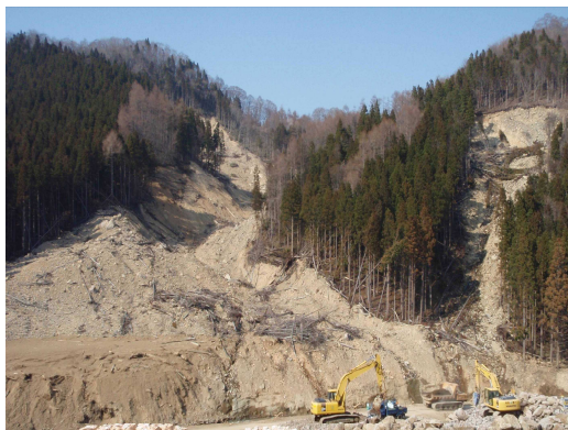
被災状況(H21年4月)
