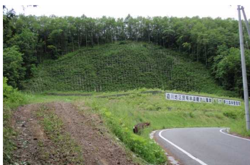
■対策工 法枠工など山腹工
