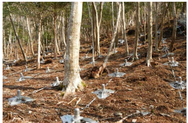
斜面を災害から守るノンフレーム工法・緑化工 (石巻市 中倉山国有林)
