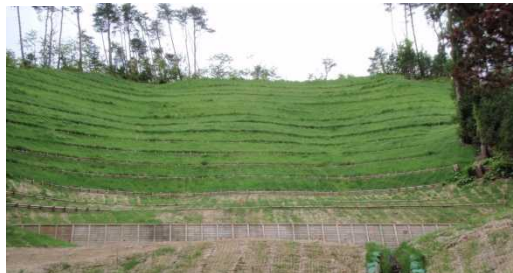
■対策工 土留工など山腹工
