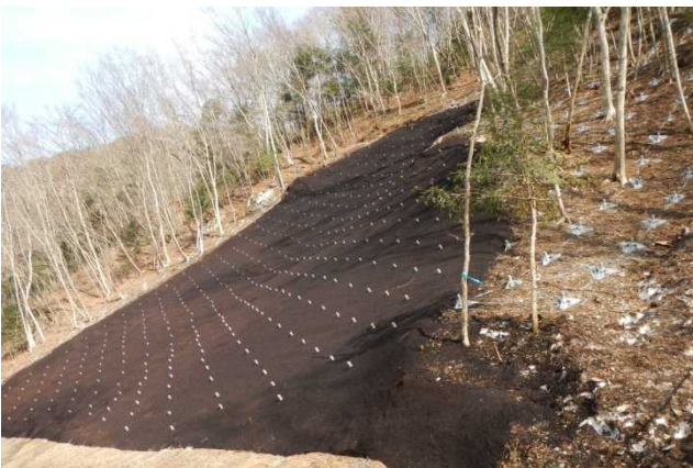
斜面を災害から守るノンフレーム工法・緑化工 (石巻市 中倉山国有林)
