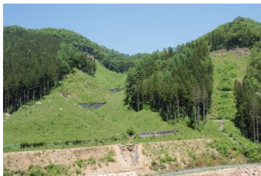
■対策工 鋼製枠谷留工、植栽工ほか
