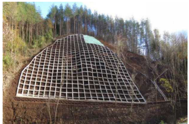
山腹崩壊地における治山工事 (登米市 銅円沢国有林)
