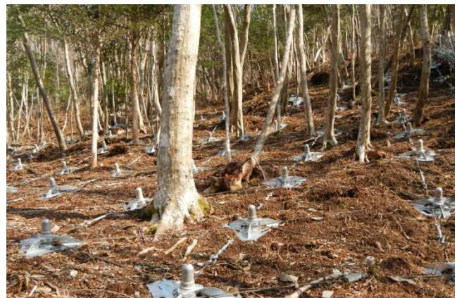
山腹斜面の崩壊等を防止するノンフレーム工（石巻市 中倉山国有林）
