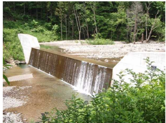
渓床・溪岸を安定化する谷止工（栗原市 深山岳国有林）
