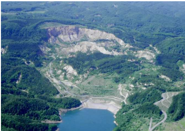
荒砥沢地すべり地全景（栗原市）
