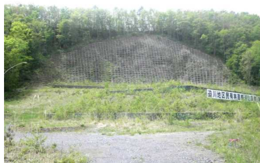
■対策工 法枠工など山腹工 民有林直轄治山事業 施工後(H28年5月)
