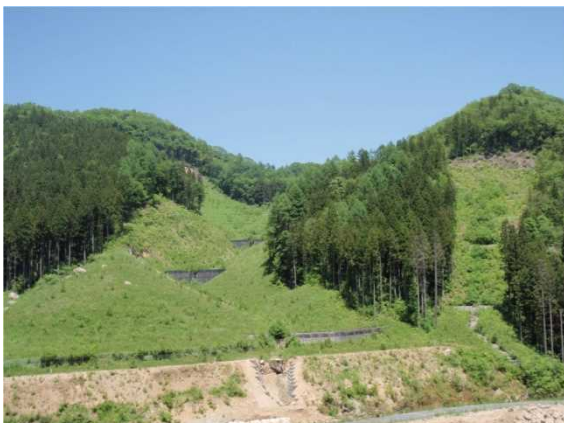
山腹崩壊地を復旧整備する山腹工（栗原市 栗駒岳国有林）
