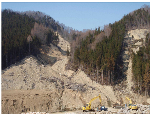
被災状況(H21年4月)
