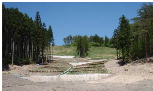
■対策工 土留工など山腹工 民有林直轄治山事業 施工後(H27年6月)
