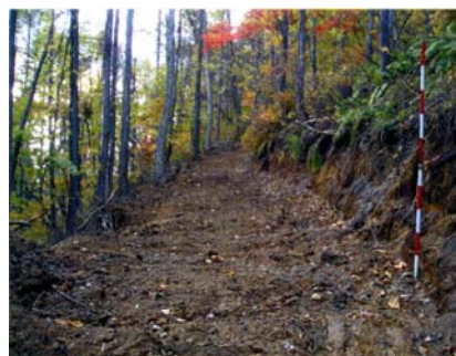
作業路の状況
