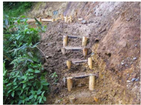
完成した歩道
