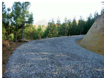
七時雨林道新設工事
