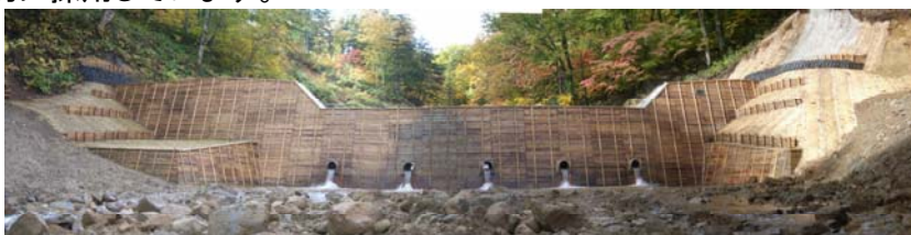
間伐の型枠を使用した赤川の治山堰堤
