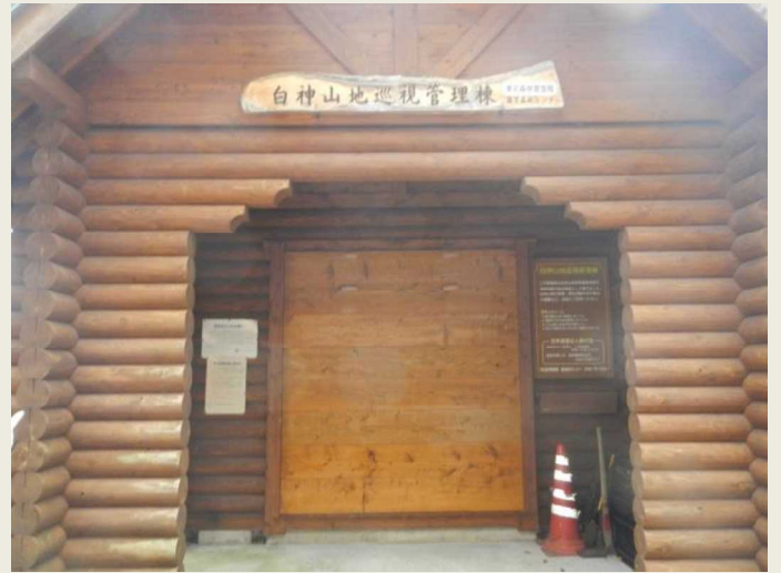
板戸施錠完成
