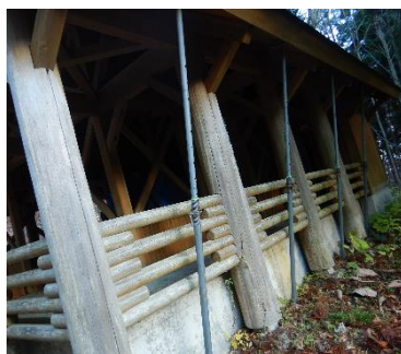
鉄の支柱で補強
