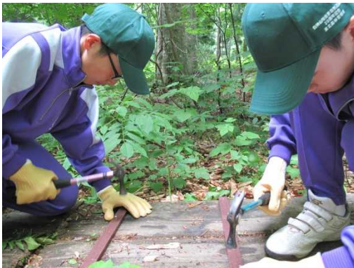
滑り止めを設置しました。より安全に通行できます。
