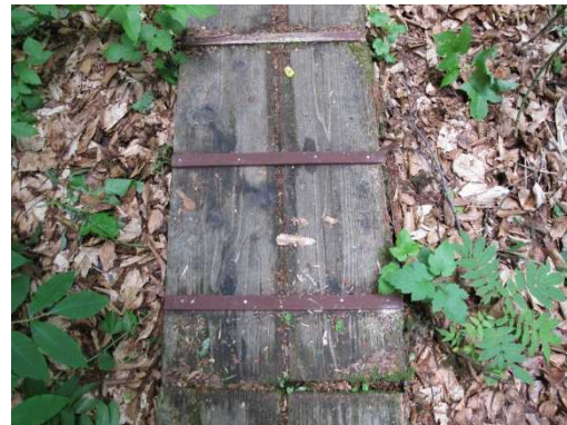
滑り止めを設置しました。より安全に通行できます。
