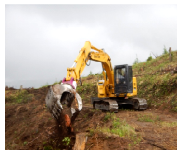
ザウルスロボによる地拵え (岩手南部森林管理署遠野支署)
