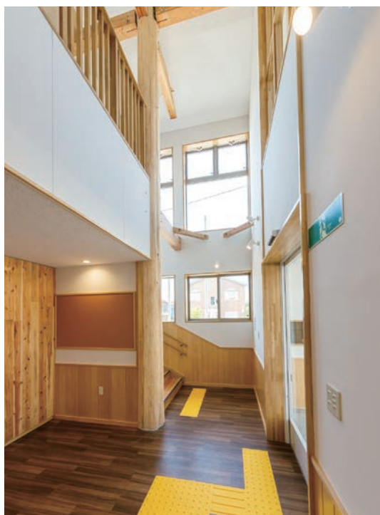
▲ 1階ホール（CLT材・丸太柱）
