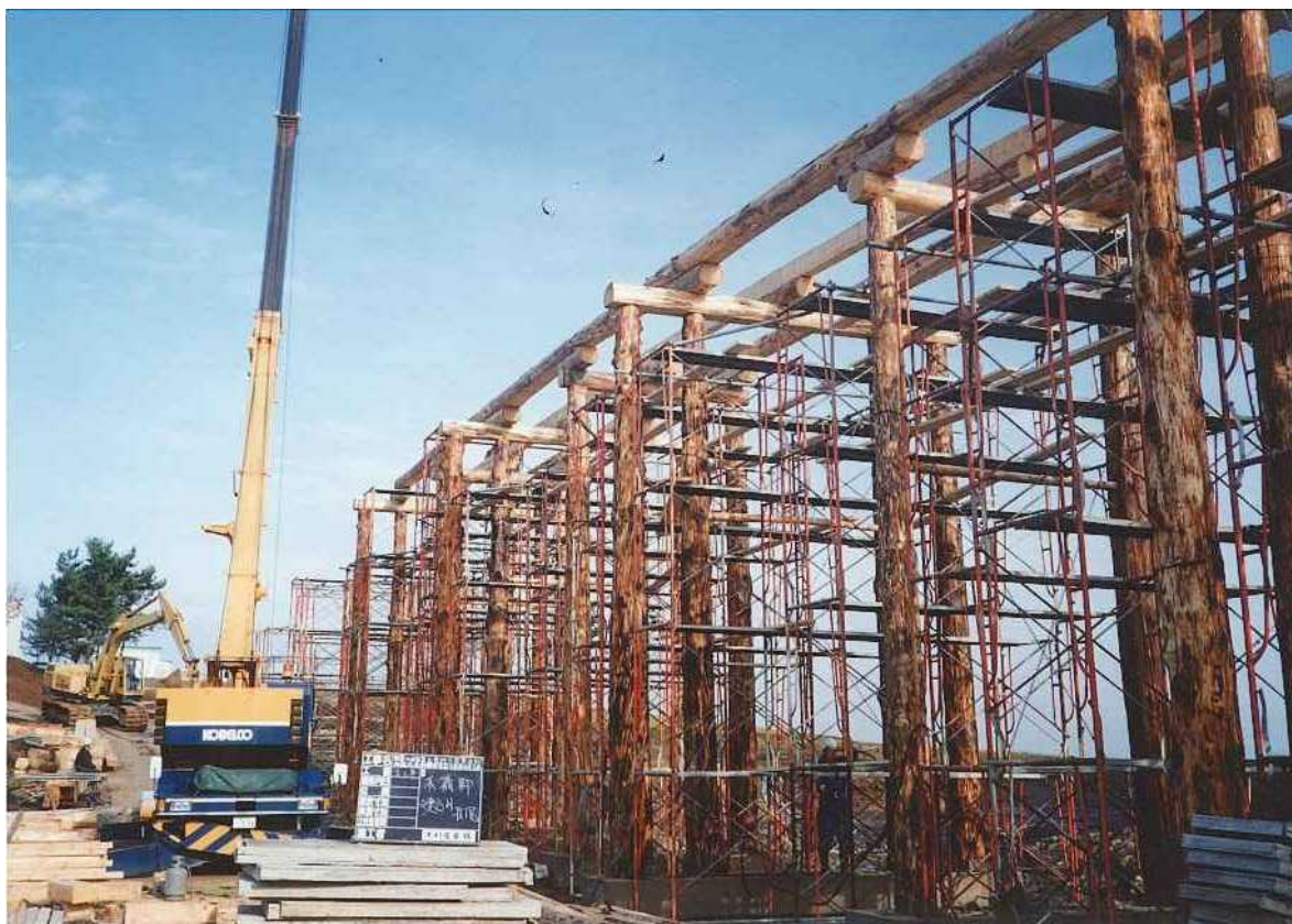
建設工事の状況
