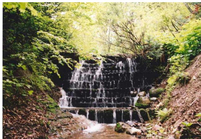
昭和29年施工8号
