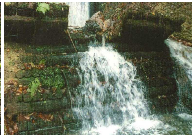
昭和32年施工3号
