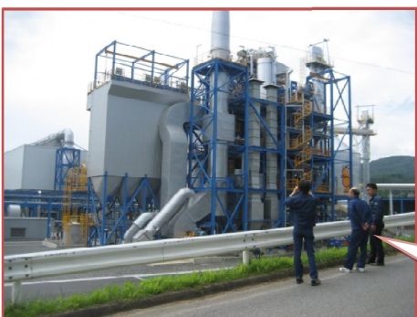
検討会前の「野田バイオマス発電所」視察の様子
