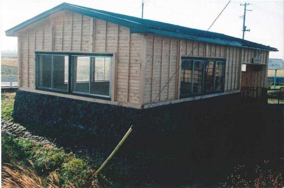
リニューアル直後の駅舎（ホーム側）
