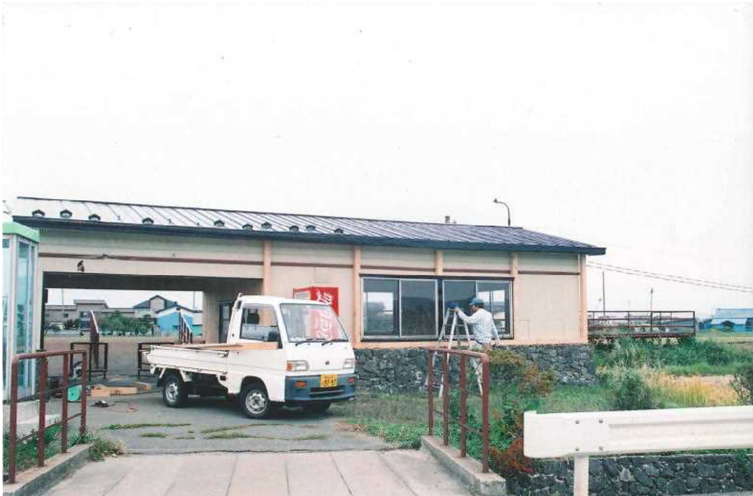
旧駅舎を利用した外装工事の様子
