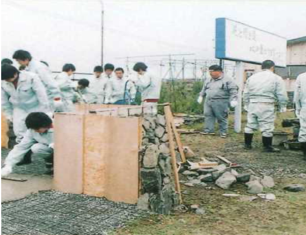
五農生による基礎工事の様子
