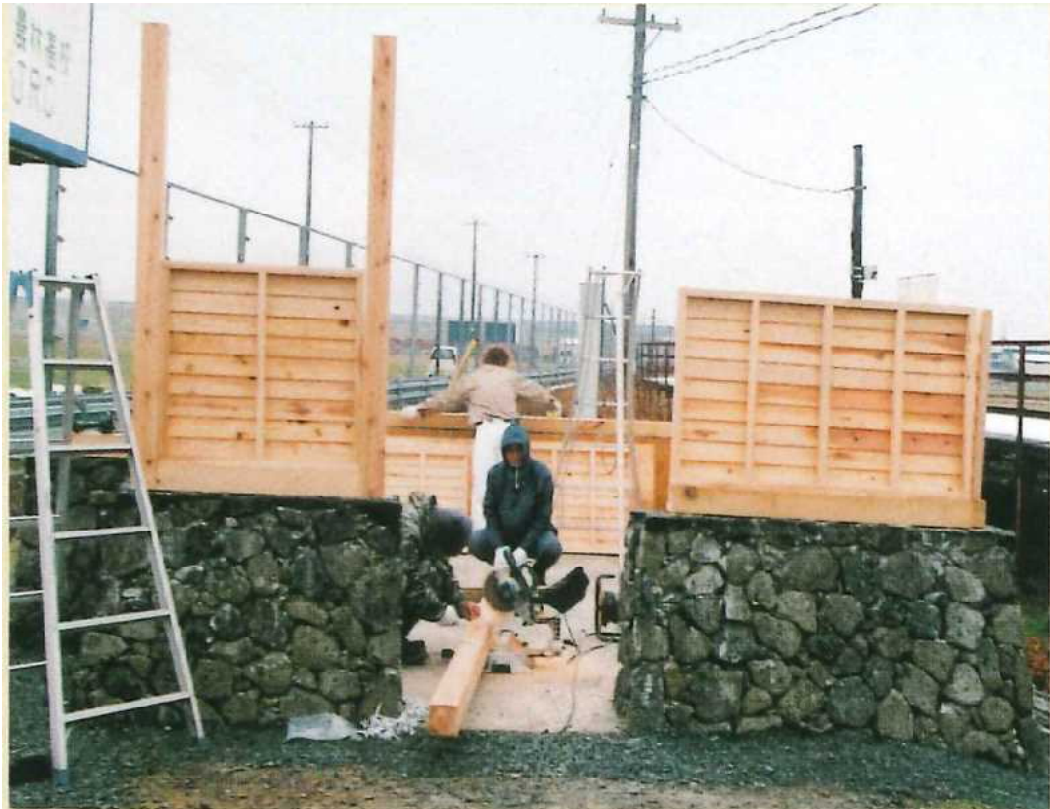
建築中の様子
