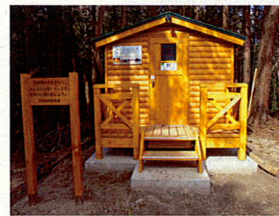
山頂パイオトイレ
