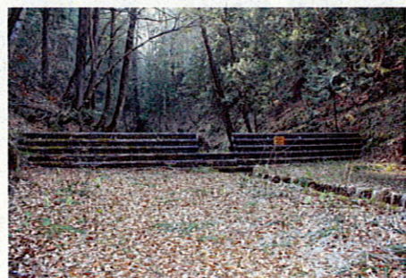
西口コース(木製堰堤)
