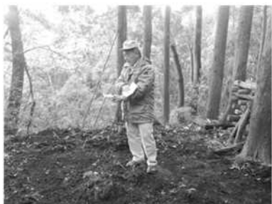
④ 除染後空間線量測定
