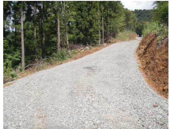
写真2. 10cm 転圧路盤
