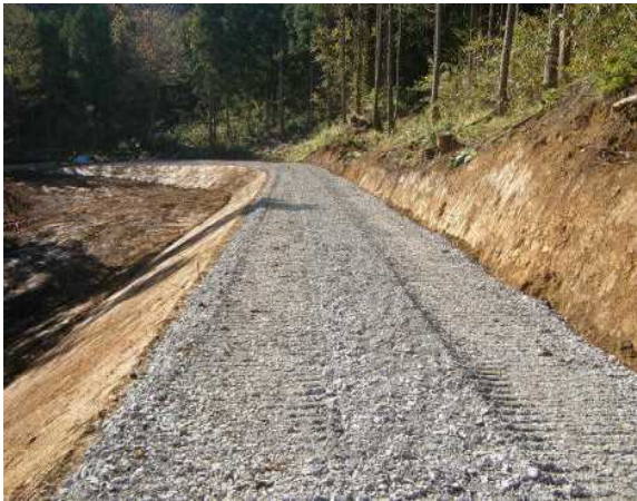
写真1. 20cm 敷均し路盤
