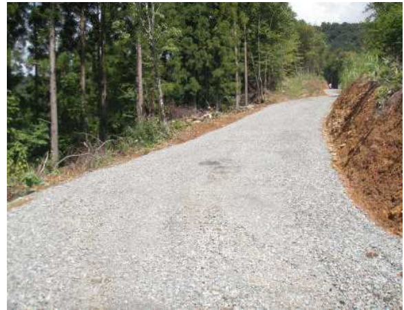
写真2. 10cm 転圧路盤
