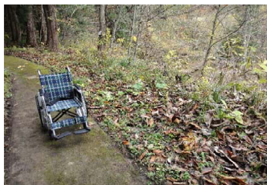
要拡幅箇所（西口272.8m地点）
