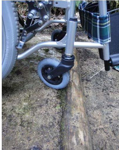
施工枠の段差
