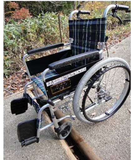
横断溝の段差（東口14.6m地点）
