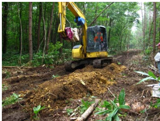
写真－1 締固め試験の盛土造成状況
