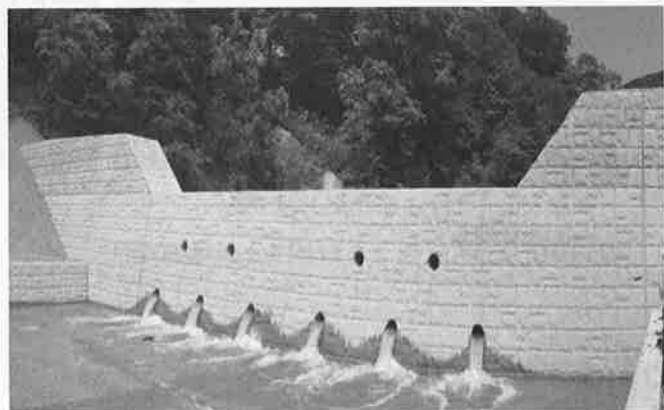
写真-9 産女川上流 溪間工完成
