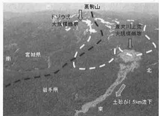
写真-1 産女川上流域 大規模崩壊と土石流
