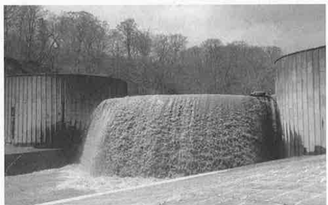
写真-14 産女川上流域で完成した治山ダムが土石流を捕捉
