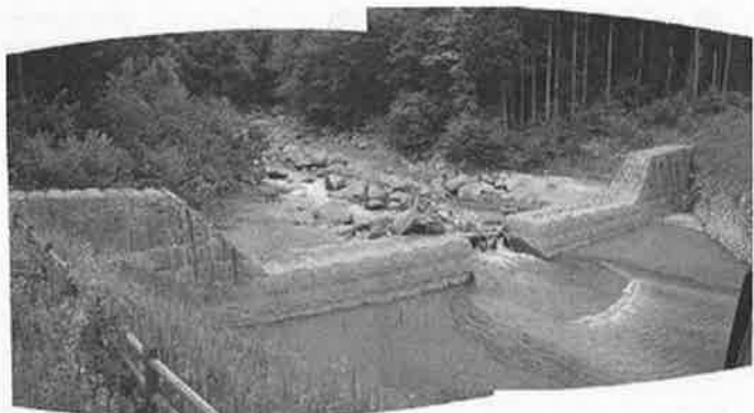
写真-13 産女川中流域の既設治山ダムの効果
