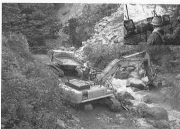
写真-5(1) 無人化施工による河道開削工事
