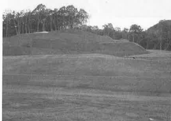
写真-11 市野々原地区地すべり Aブロック頭部排土工事完成
