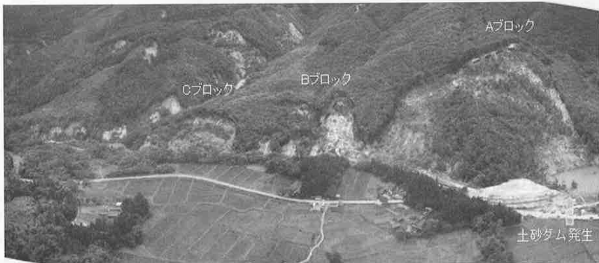
写真-4 市野々原地区地すべり
