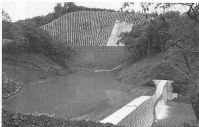
写真-10 磐井川上流 山腹工完成
