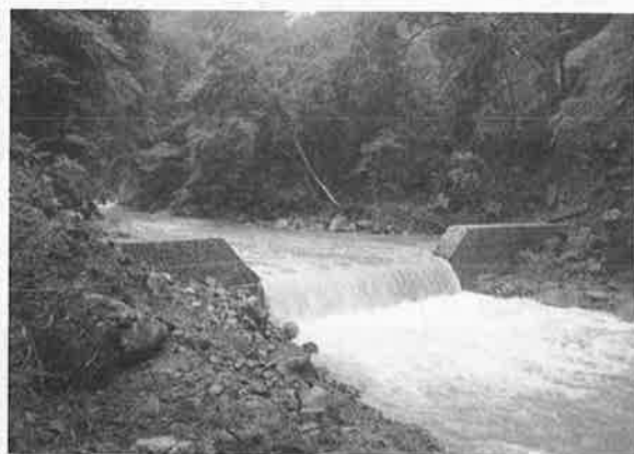
写真-5(2) 鋼製カゴ枠工による応急復旧工事
