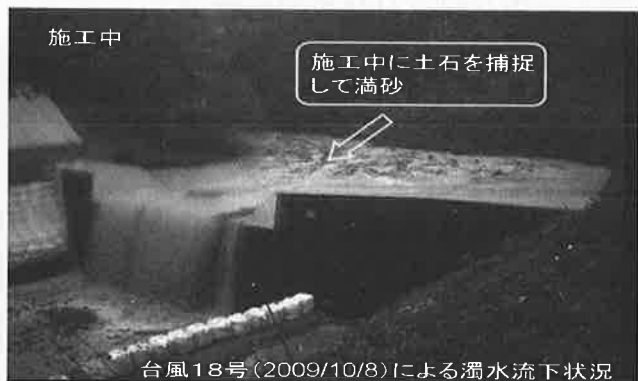
写真-15 磐井川上流で施工中の治山ダムが土石流を捕捉
