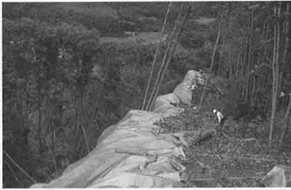
写真-6 市野々原地区地すべり
