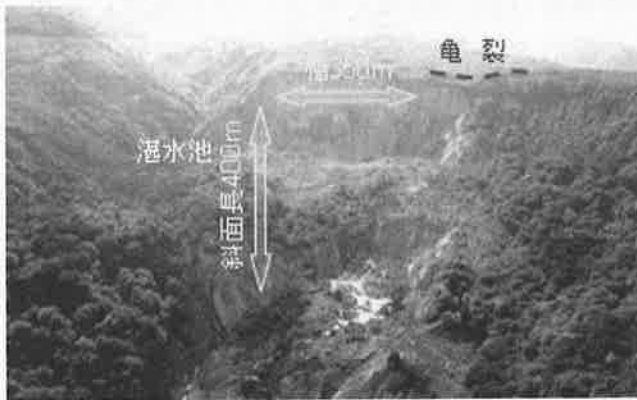
写真-2 産女川上流大崩壊地
