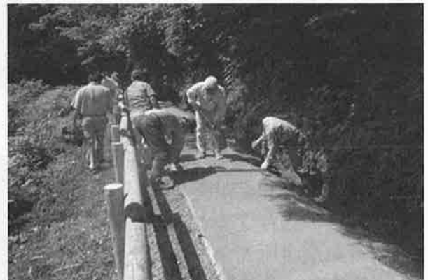
遊歩道の整備
