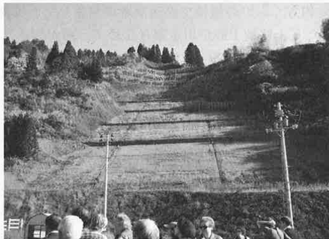
中越地震の土砂災害復旧の様子
