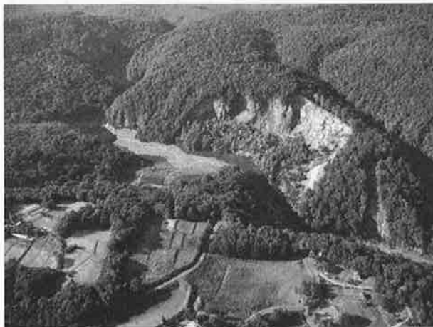
駒の湯温泉の土石流災害
