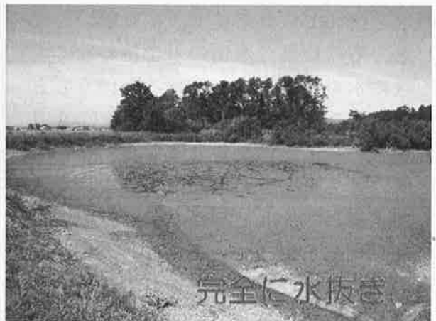
写真5 水抜き後の松島ため池
