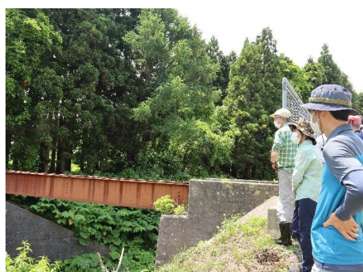
長川林道鉄橋跡
