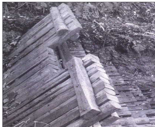
図2 昭和32年施工3号木製堰堤
