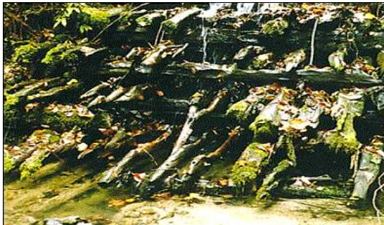
図1-1 大正5年施工2号木製堰堤
