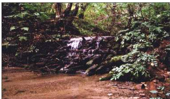
図6 調査当時の2号堰堤
