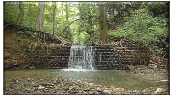
図1-2 昭和29年施工9号木製堰堤
