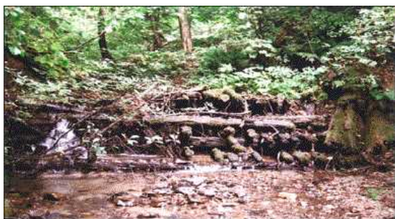
図8 調査当時の5号堰堤
