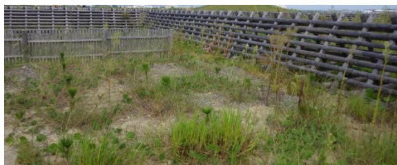
写真－７ 根鉢周辺３個施肥区の下草の繁茂状況
