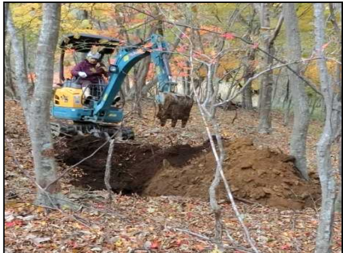
図4：バックホウでの掘削の様子
