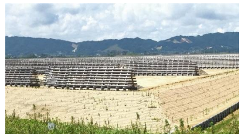
写真－2 盛土完了後
