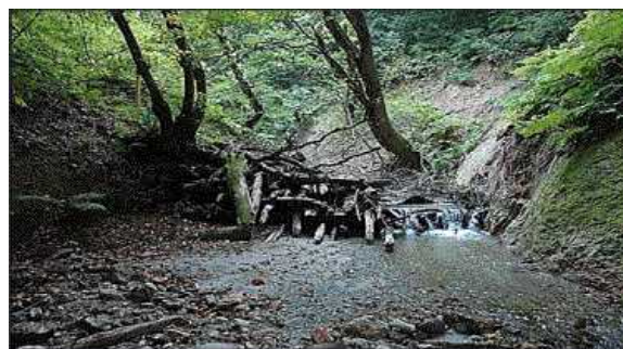
図7 現在の2号堰堤
