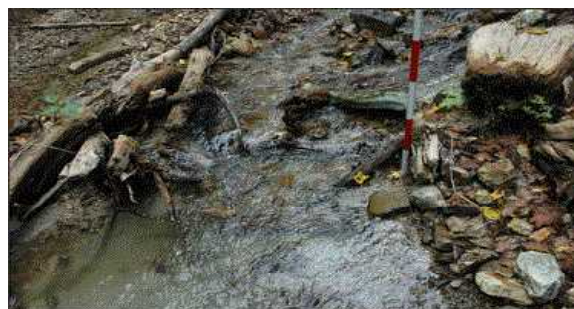
図9 現在の5号堰堤
