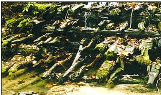
図1-1 大正5年施工2号木製堰堤
