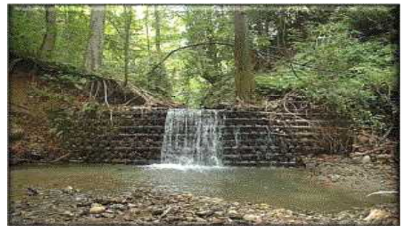
図1-2 昭和29年施工9号木製堰堤
