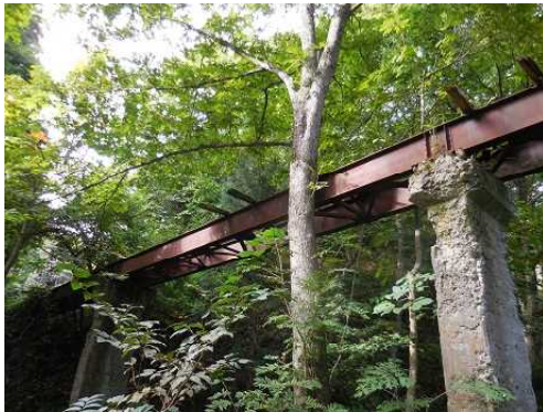
小田川支線に残る鋼製ガーター橋
