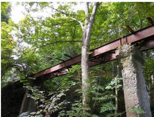
小田川支線に残る鋼製ガーター橋
