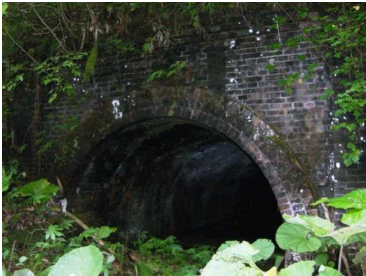
相の股隧道のレンガ張りポータル
