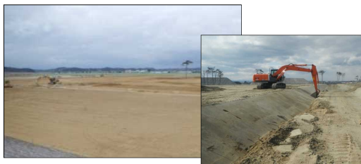
生育基盤盛土を造成
