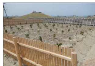
防風柵を設置し、苗木を植栽
