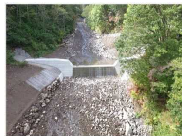
完成した治山ダムの様子
