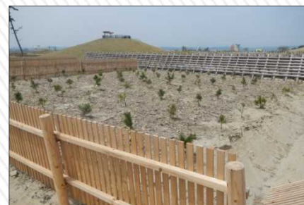
防風柵を設置し、苗木を植栽
