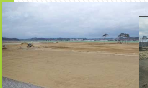
生育基盤盛土を造成
