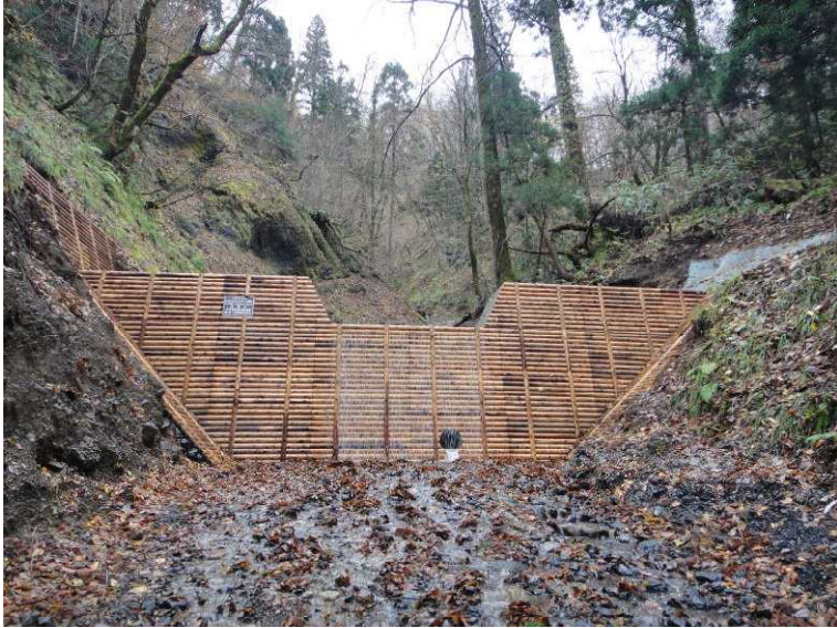
大又沢治山工事における木材利用の様子
