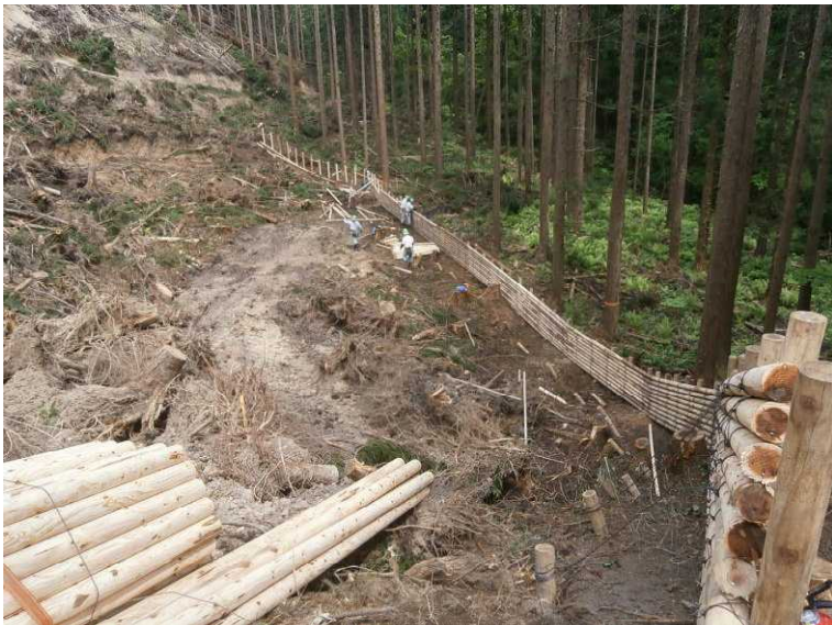
割山沢林道新設工事における木材利用の様子
