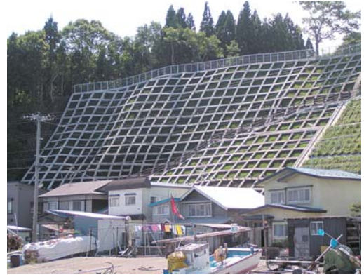
モルタル法枠工
