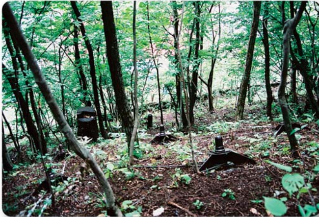
ノンフレーム工法による施工
