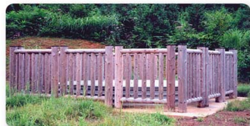
間伐材でつくった集水井安全柵 磐井川地区(岩手県一関市)〈岩手南部森林管理署〉
