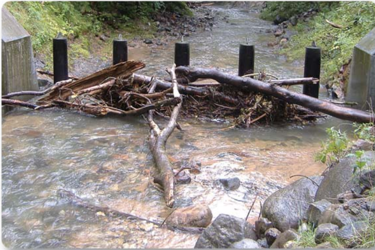
スリットダムでとらえられた流木
