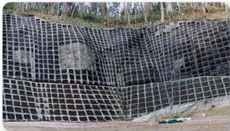
モルタルを吹付けた法枠工
