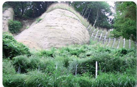
工事の完成後
