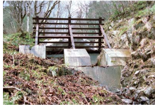
コンクリートと鋼材でつくられたなだれ予防柵
