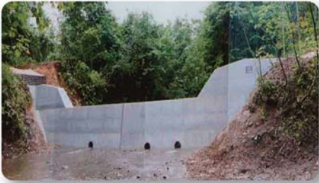
コンクリート治山ダム
