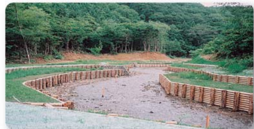
間伐材でつくった護岸工 熊取沢(秋田県鹿角市)〈米代東部森林管理署〉
