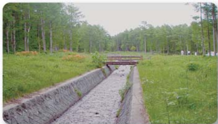
コンクリートブロック護岸工
