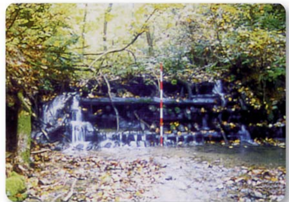
大正5年にヒバ材でつくった木製治山ダム
