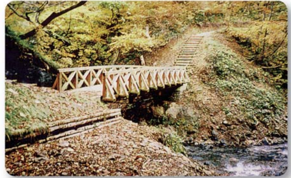
木製歩道橋 鮭川地区（山形県鮭川村）〈最上支署〉
