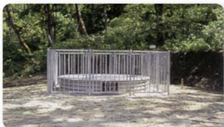
鋼製の集水井安全柵
