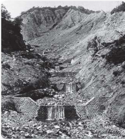
昭和初期につくられた治山ダム群
