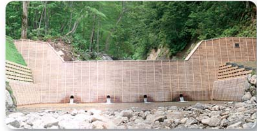
木製の型枠をそのまま残したコンクリート治山ダム 倉形沢(岩手県八幡平市)〈岩手北部森林管理署〉
