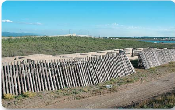
丸太防風柵 屏風山（青森県つがる市）〈金木支署〉
