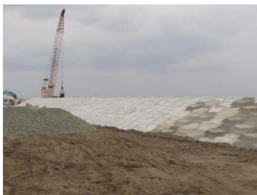
左：防潮護岸工の復旧工事、右：丸太静砂工 （青森県三沢市三沢海岸（三八上北森林管理署））
