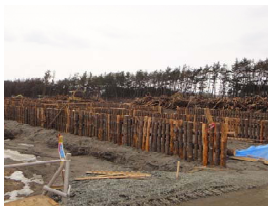
左：防潮護岸工の復旧工事、右：丸太静砂工 （青森県三沢市三沢海岸（三八上北森林管理署））
