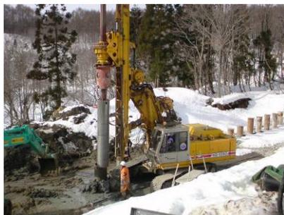
地すべり対策工事（鋼管杭打工）のようす
