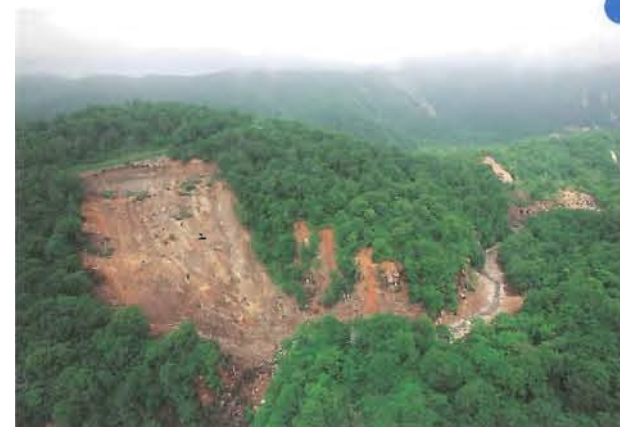
磐井川 国道直下の大規模崩壊により国道342号が被災
