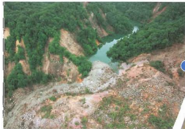
湯浜地区 崩落した土砂による河道閉塞状況
