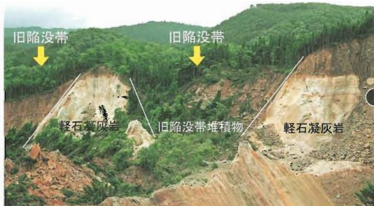
右側側面には「旧陥没帯堆積物の断面」が残存
