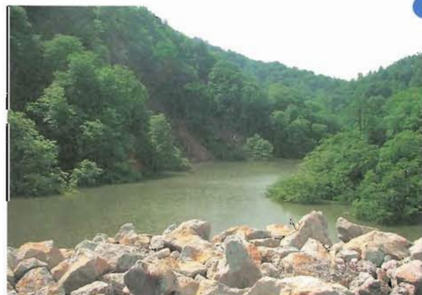
湯浜地区 河道閉塞による湛水状況
