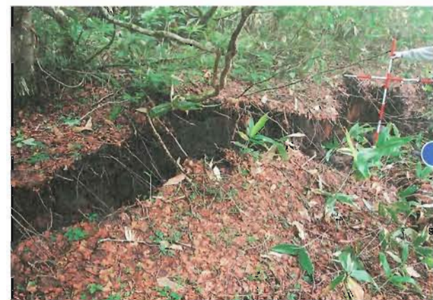
産女川上流 地すべり頭部の背後に確認された拡大性の亀裂
