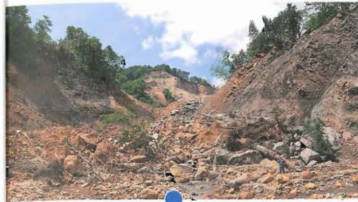
腰抜沢 山腹崩壊状況
