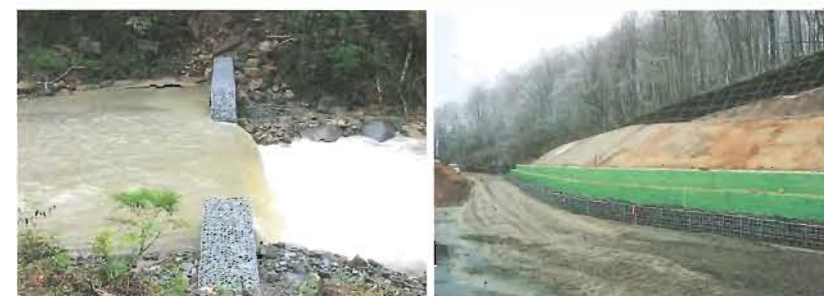
尿前沢 溪間工 谷止工（カゴ枠工）
