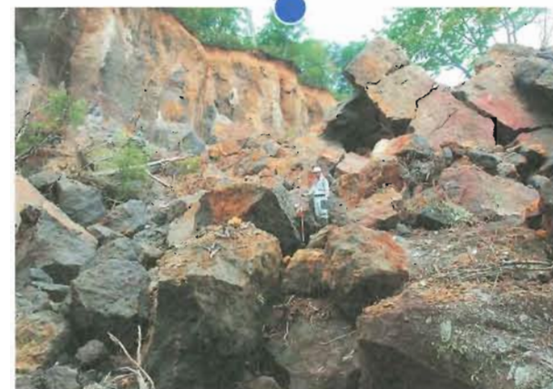
磐井川 山腹崩壊により崩れ落ちて溪流を埋めた巨石群
