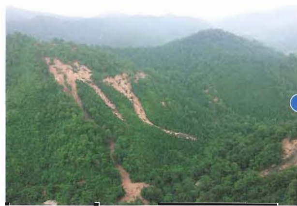
タモノキ沢左岸 山腹崩壊状況
