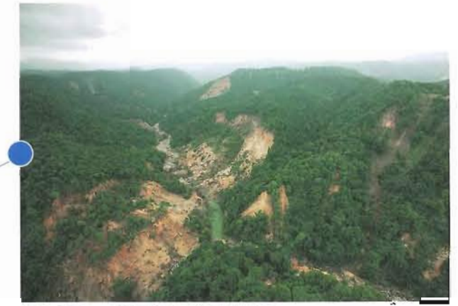
河原小屋沢 山腹崩壊と河道閉塞状況
