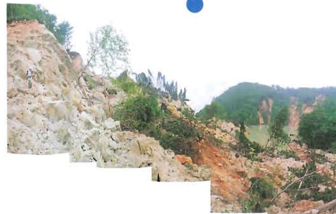
シヅミクラ沢 地すべり地内の荒廃状況と末端部湛水状況
