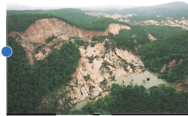
シヅミクラ沢 地すべり全景と湛水状況
