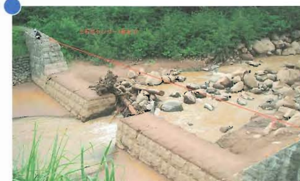
既設の治山ダムにより土石が捕捉され、下流側には泥流のみが流下し、下流域への被害を最小限に抑制している。なお、当箇所には土石流センサーを設置し、警戒している
