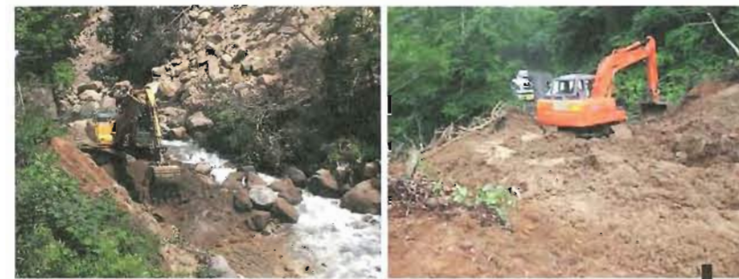
尿前沢 無人バックホウによる河道開削工事
