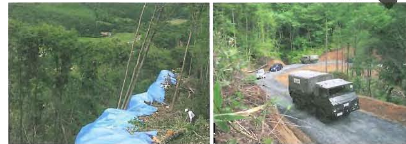
市野々原 遮水シートによる二次災害防止措置
