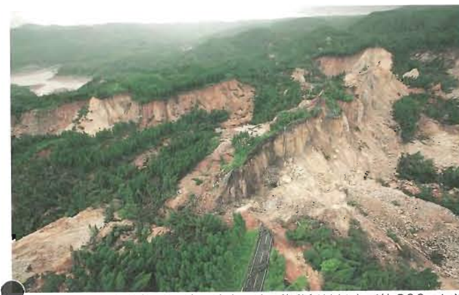
寸断された市道荒砥沢線 地すべりの移動量は最大で約300mに達する
