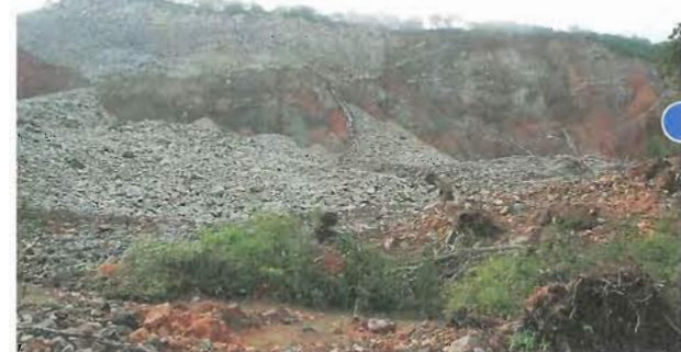
産女川上流 地すべり頭部にむき出しになった巨大な滑落崖
