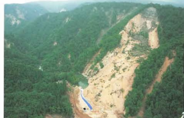
一迫川湯ノ倉地区 山腹崩壊と河道閉塞状況
