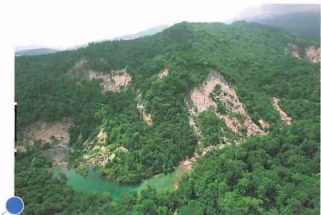
尿前沢右岸 地すべりによる河道閉塞状況
