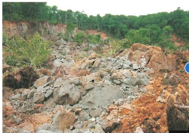
ヒアヒクラ沢 山腹崩壊地内の荒廃状況
