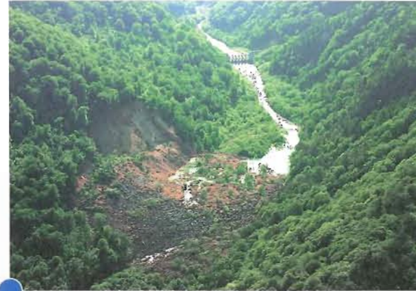
磐井川 大規模な山腹崩壊と河道閉塞状況
