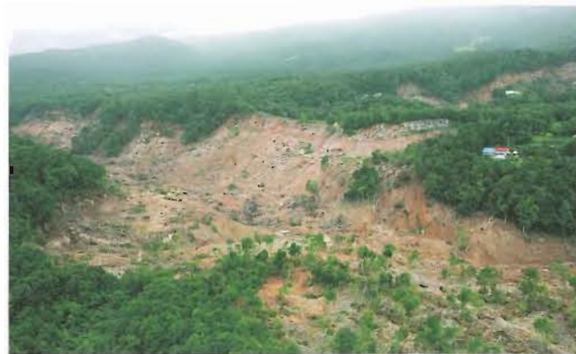
冷沢内の溪岸斜面のほとんどの部分で山腹崩壊が発生
