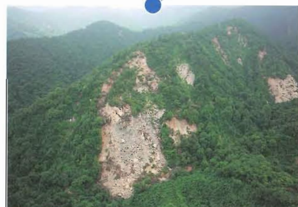
タモノキ沢上流右岸 山腹崩壊状況
