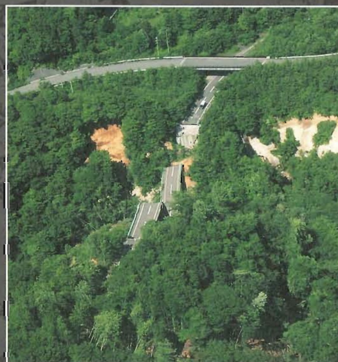
祭時(まつるへ)大橋 地すべりにより橋台・橋脚ごと移動し、落下したと考えられている [国道342号・岩手県一関市巖美町]
