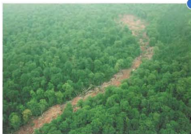
マダラ沢 山腹崩壊と土石流
