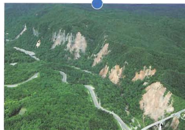
尿前沢下流左岸の山腹崩壊群 既設の治山ダムが上流域で土石を捕捉し、下流域及び胆沢川への流出を防いでいる
