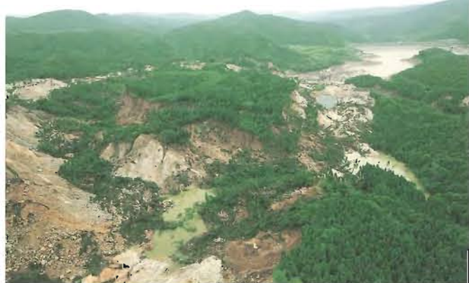
地すべり中央~末端近くの移動土塊(写真中央)は、変形・沈降が少なく、ほぼ水平方向に移動(地すべり頭部上空から下方の移動土塊を望む)
