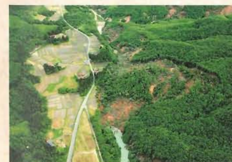
地すべり 市野々原地区(国際航業株式会社提供)
