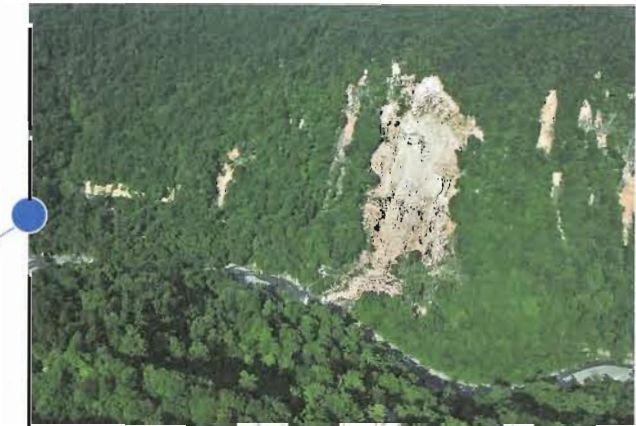
尿前沢中流左岸 山腹崩壊状況
