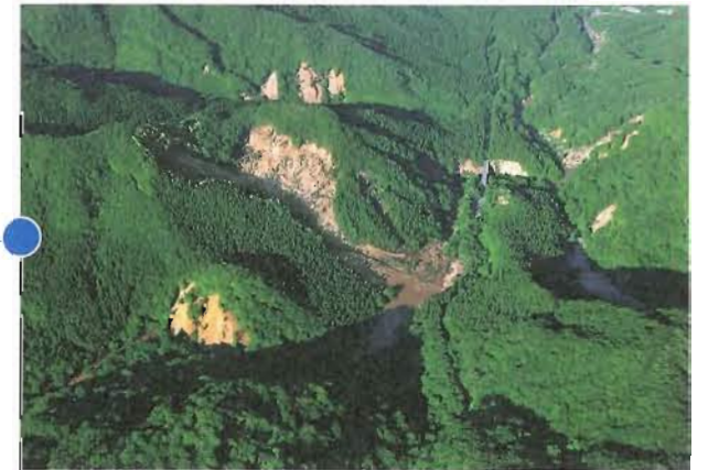
三迫川 行者滝に隣接した山腹崩壊
