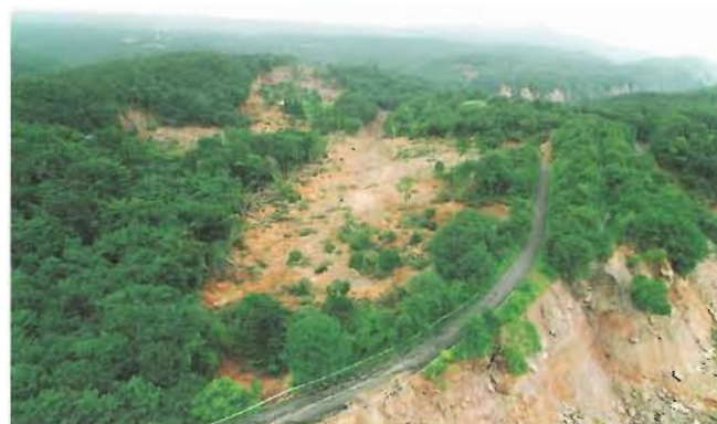
御沢支溪 山腹崩壊と市道被災状況
