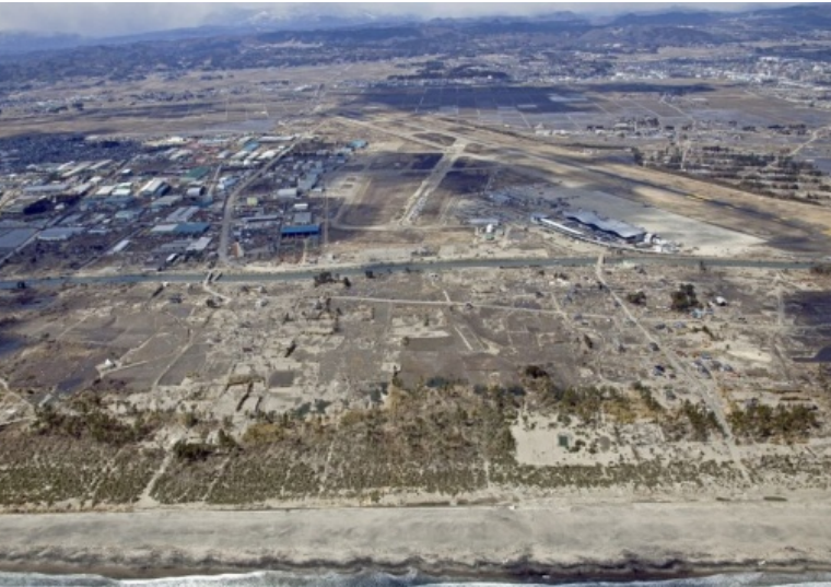
仙台空港周辺の被災状況 提供：社団法人東北建設協会
