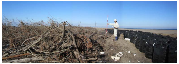
汀線から約70m、岩沼区域南端部 海岸線付近の海岸林は壊滅、背後の大型土嚢は応急復旧対策
