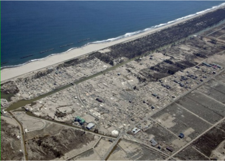
荒浜周辺の被災状況 提供：社団法人東北建設協会
