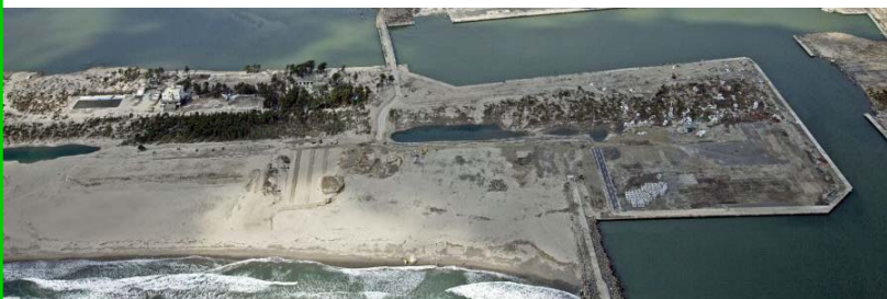
関上浜周辺の被災状況 提供：社団法人東北建設協会
