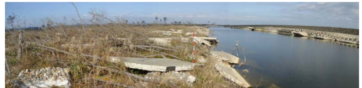
汀線から約130m、山元区域北端部付近 防潮堤背面は大きく洗掘される
