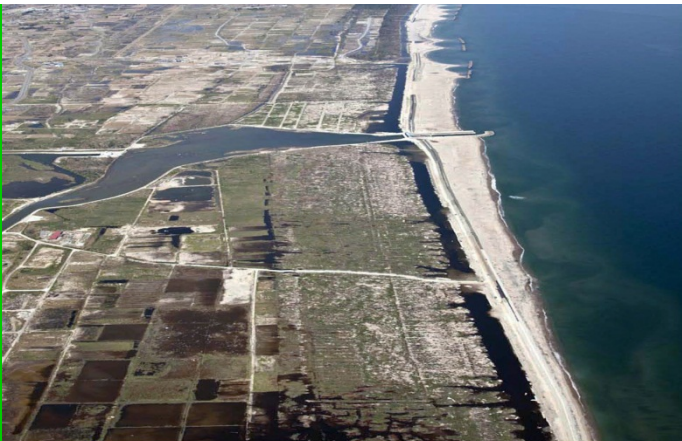
牛橋河口付近の被災状況 提供: 社団法人東北建設協会 (加工)
