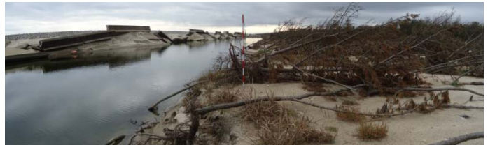
汀線から100m、亶理区域北部 防潮堤は倒壊し、背面は大きく洗掘され海岸林もろとも流出
